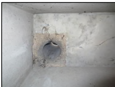
Photo N° 1237 AMIANTE CIMENT -- PLACARDS TECHNIQUES +3 Plafonds Ventilation haute (Fibres- ciment)
